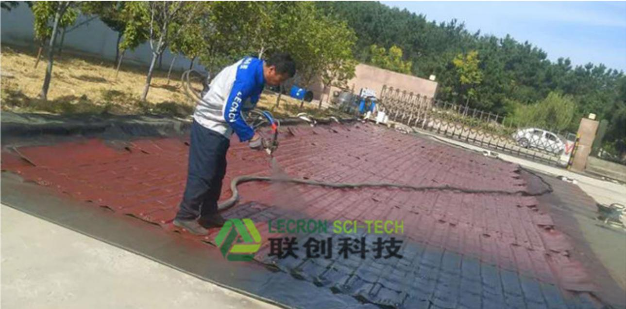
大家都知道防水工程可以使用聚脲弹性体防水涂料，下面联创科技讲解一下聚脲防水施工时应注意什么？ 聚脲防水施工工艺：防水层基面清理-喷涂基层处理剂-喷涂聚脲弹性体防水涂料-喷涂聚脲脂肪族面层。 1) 清理基层：防水层施工前进行基层验收，应做到表面平整，坡度棱角分明、无尖锐异、不起砂、不起皮、无蜂窝麻面、无凹凸不平等缺点，平整度用4m靠尺检验。基面打磨的尘土，施工残留水泥浆，砂浆块及油污等杂物需要打扫干净，然后先使用清水冲洗，晾干后再用高压风吹干，使基层的表面保持干燥，更不可以发现明水。 2) 喷涂基层处理剂：适合采用喷涂设备将防水涂料均匀喷涂于基层表面，又可以采用刷涂，辊涂的方式不漏涂、不堆积涂刷于基层表面。 3) 喷涂聚脲弹性防水涂料：采用\*\*喷涂设备进行施工，防水涂料由A□B两种组份组成，使用时需要按产品使用说明书配比进行，每种称量误差不大于2%。 以上内容\*供参考，有需要欢迎来电咨询，我们将竭诚为您服务！联创科技规模大，产量高，品种多，规格全，质量优，价格廉。临沂耐腐蚀聚脲报价
